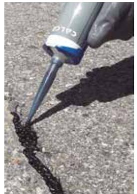
**Reparación de hormigón no estructural**
